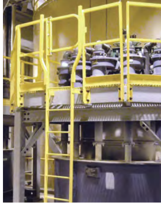
Plataforma elevada con guardarriel de protección.
